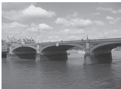
図 21 テムズ川にかかる橋
