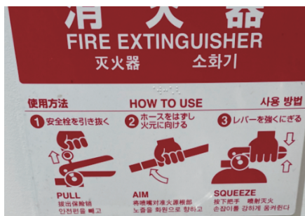
図 6 消火器／소화기(消火器)(横浜)
